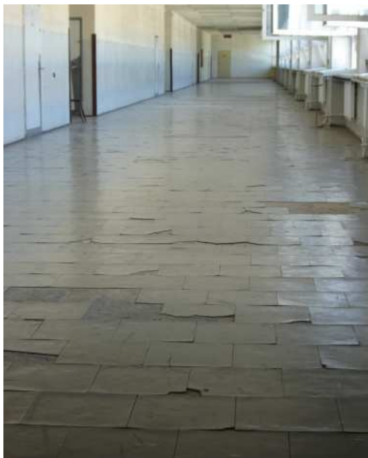
Fot. 13. KWP Łódź - OPP Łódź - korytarz na bloku szkolnym - stan w dniu 29.06.2005 r.
