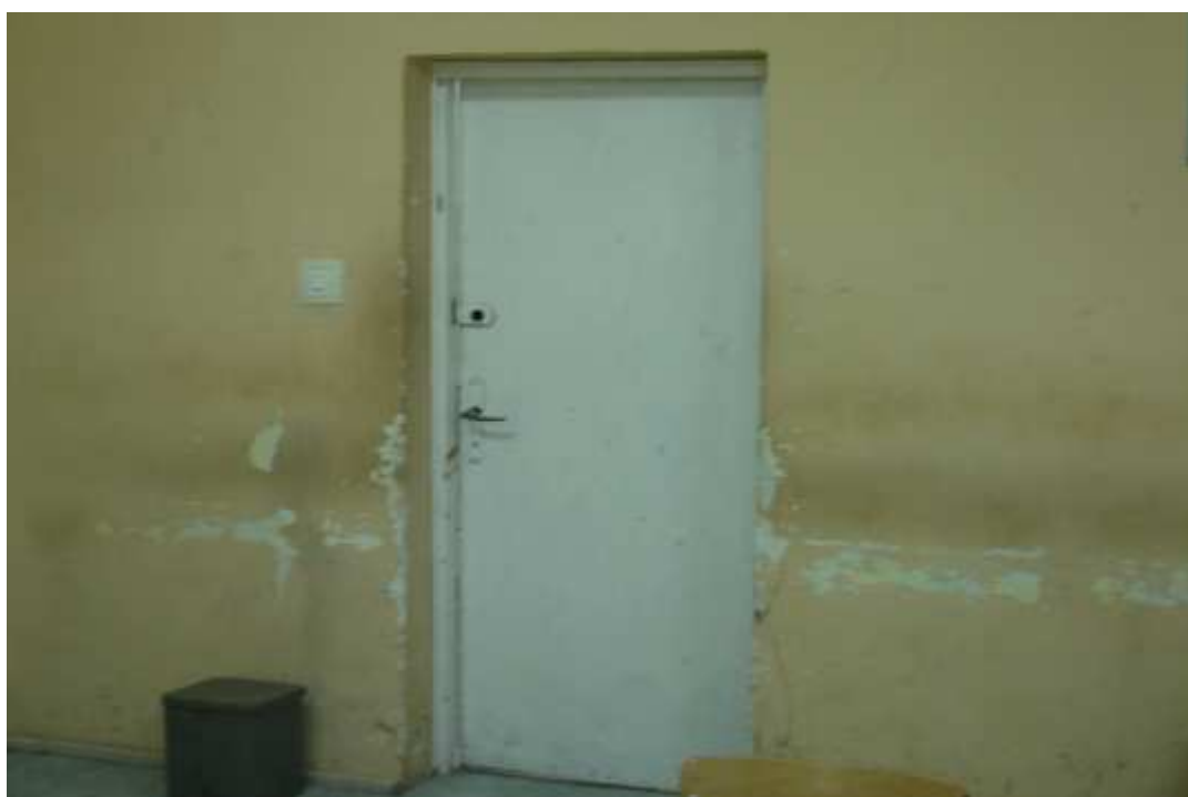
Fot. 14. KWP Łódź - OPP Łódź - świetlica kompanii kandydackiej - stan w dniu 29.06.2005 r.
