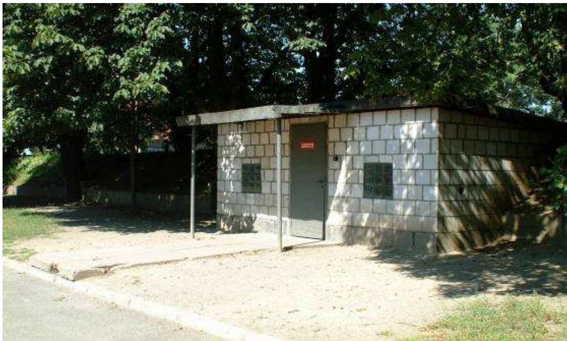
Fot. 27. KWP Poznań - OPP i OSP Poznań - strzelnica tunelowa - stan w dniu 30.08.2005 r.
