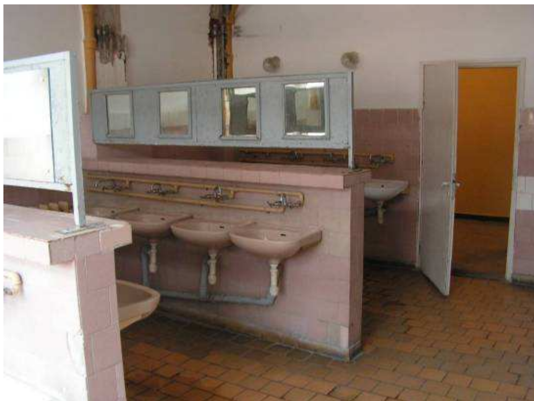
Fot. 12. KWP Gdańsk - OSP Gdańsk - umywalnia - stan w dniu 28.09.2005 r.
